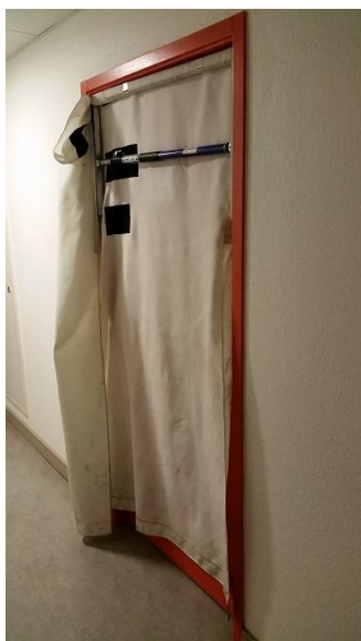
Illustration n°1 : installation d'un « stoppeur de fumées »
