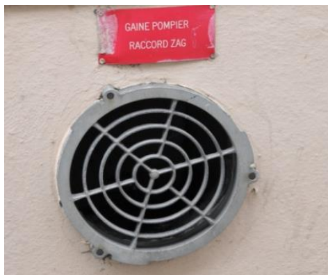
Illustration n°1 : Un raccord « ZAG » en façade
