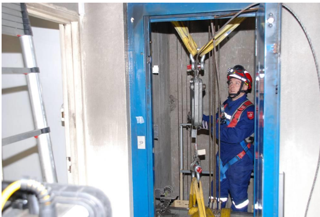
Exemple de mouflage lors d'une intervention de sécurisation d'une cabine d'ascenseur. © SDIS 95
