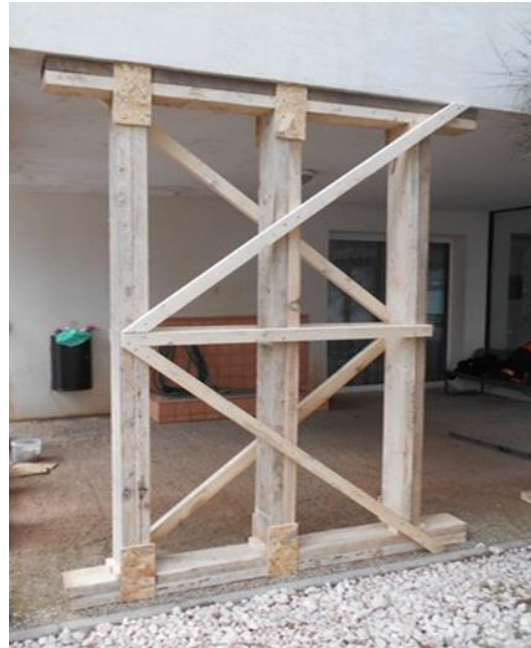
Exemple d'étais multi-poteaux © FORMISC
