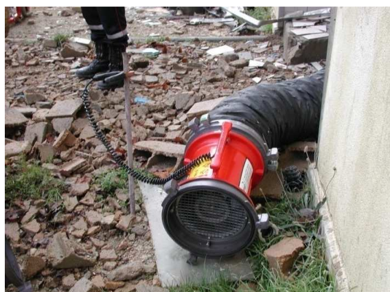
Illustration n°2 : Utilisation d'un hydro ventilateur
