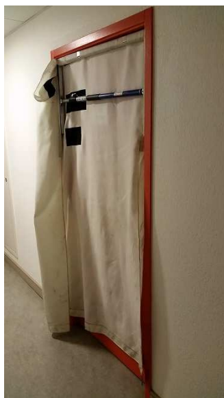
Illustration n°1 : installation d'un « stoppeur de fumées »
